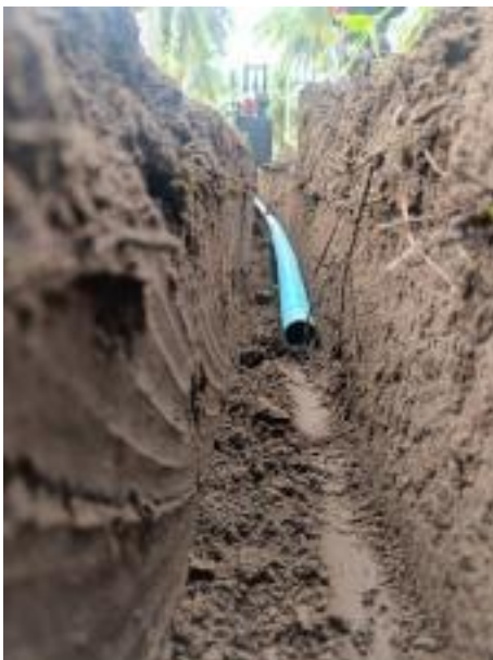
ภาพที่ 13 ความลึกร่องที่ได้จากเครื่องขุดดินฝังท่อ
