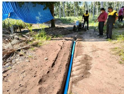
ภาพที่ 11 เปรียบเทียบการใช้แรงงานและเครื่องขุดดินขุด
