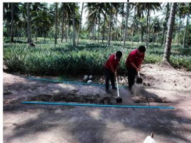
ใช้แรงงานขุด
